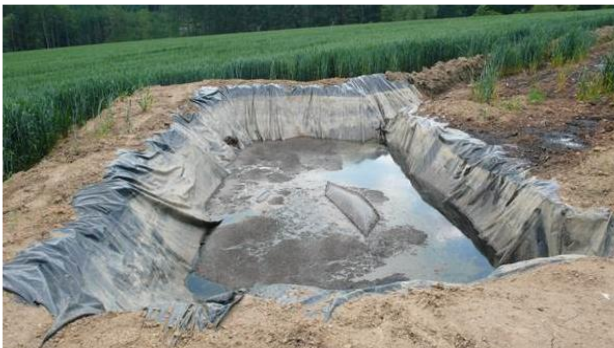
Foto: Jímka opatřená fólií
