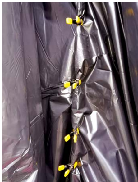
Obrázek 2.4.4: Zarolovaný spoj zafixovaný pružinovými svorkami
