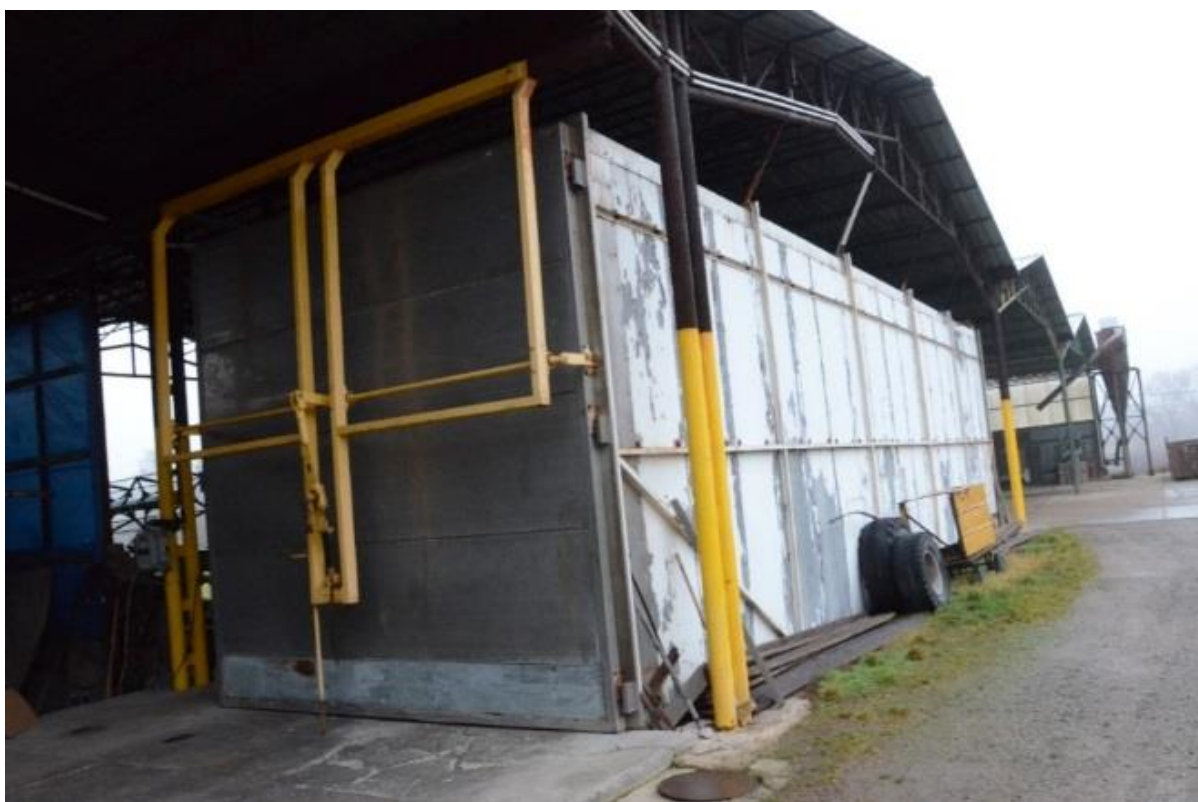
Obr. č. 5 – Propařovací tunel na výrobu substrátu v provozních podmínkách
